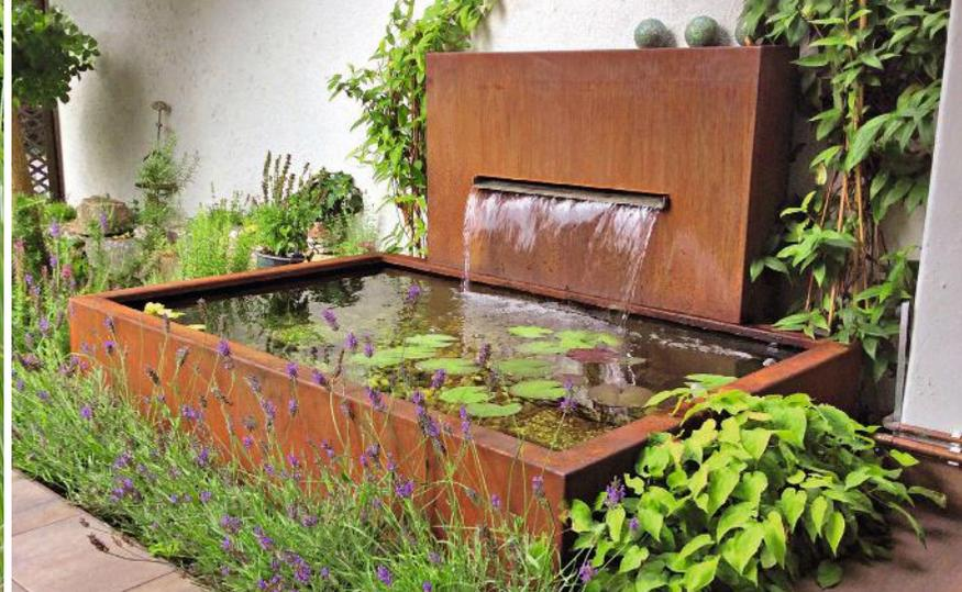
Bei ständigem Kontakt mit Wasser rostet Cortenstahl langsam weiter und das Wasser verfärbt sich. Daher müssen Wasserspiele wie die Schale im Foto links täglich – zum Beispiel über Nacht – abgestellt werden, damit die Stahlflächen immer wieder abtrocknen können. Keinen direkten Wasserkontakt gibt es bei diesem Brunnen: Der Einlauf ist aus Edelstahl, das Becken innen mit Kunststoff beschichtet (beide Objekte von Gartenmetall)
